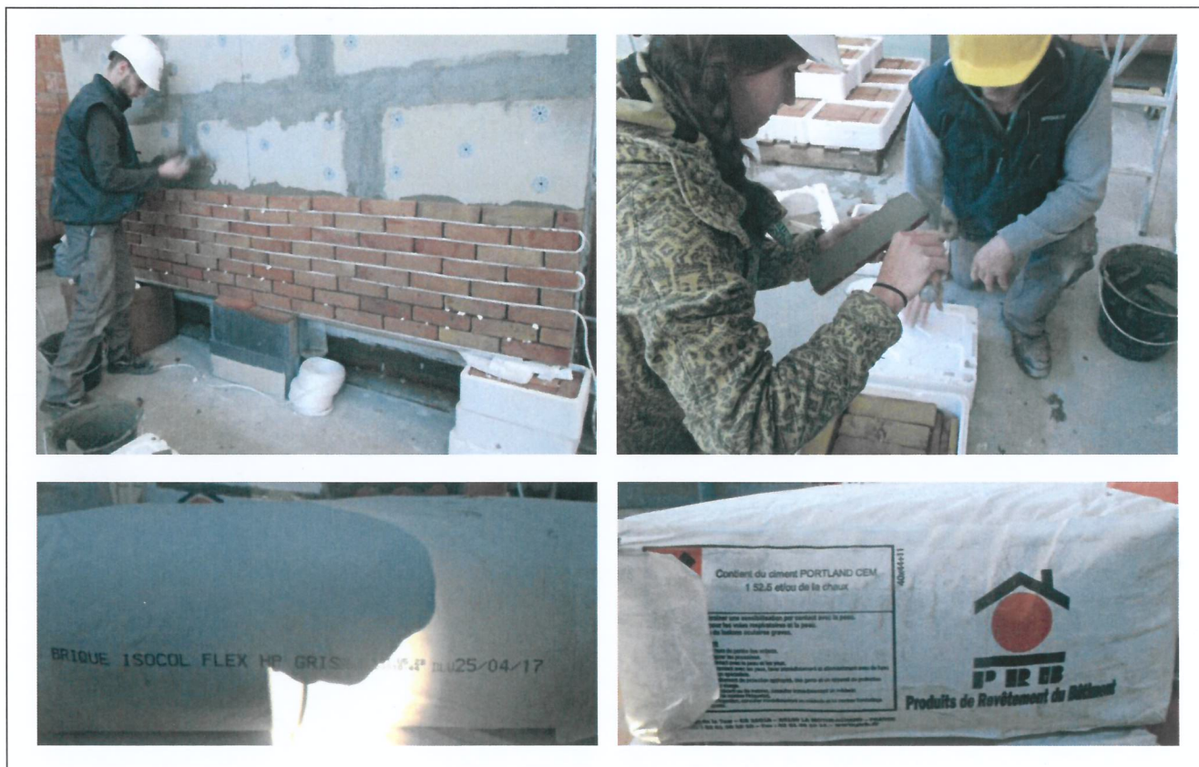
Photo 4 : Double encollage des plaquettes, et emploi d'une cordelette pour maîtriser les joints de 8mm
